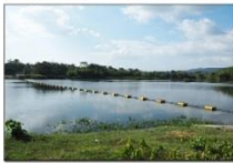
อ่างเก็บน้ำท่าสี่
