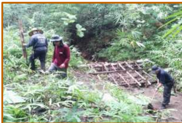
ภาพแนวกันชน (Buffer Zone) และการสร้างฝายดักตะกอนบริเวณลำห้วยที่อยู่ในพื้นที่ทำไม้
