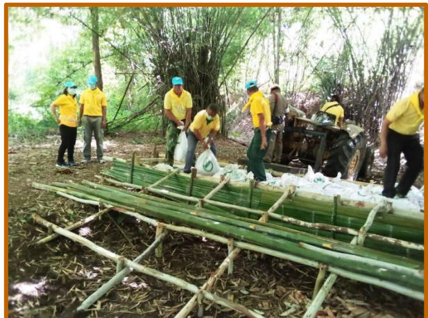
ภาพแนวกันชน (Buffer Zone) และการสร้างฝายดักตะกอนบริเวณลำห้วยที่อยู่ในพื้นที่ทำไม้
